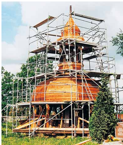
Abb. 8: Kirchturm in Ellersleben: Recht leichtes Instandsetzen auf dem Boden ...
