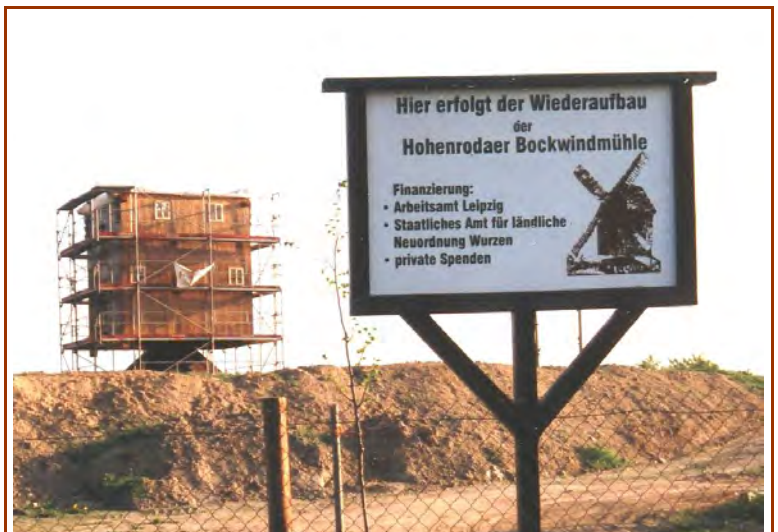
Wiederaufbau des Mühlenhauses
