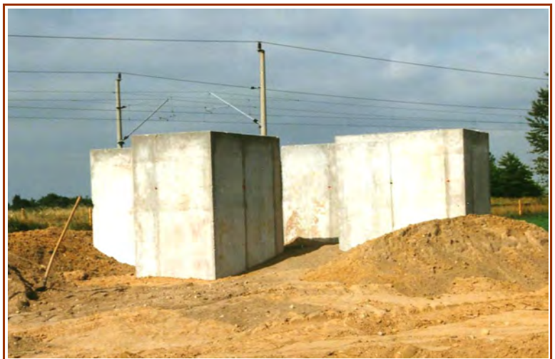
neue Stahlbetonfundamente für den Bockstuhl
