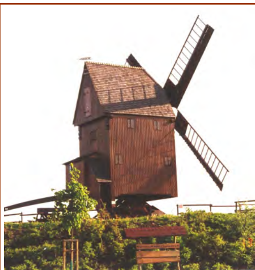
Windmühle nach der Rekonstruktion
