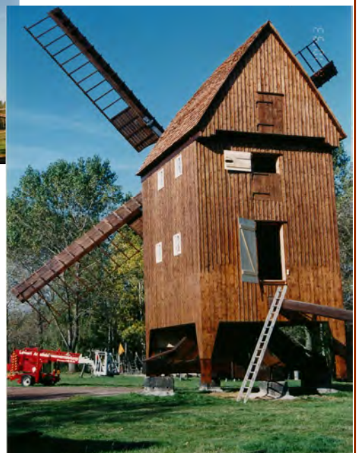
Mühle nach Wiederaufbau und Sanierung
