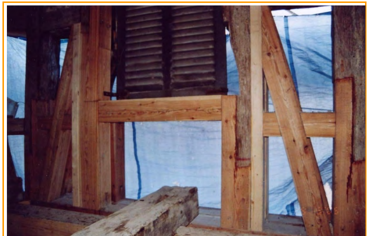
Sanierung Fachwerkkonstruktion - Turmschaft
