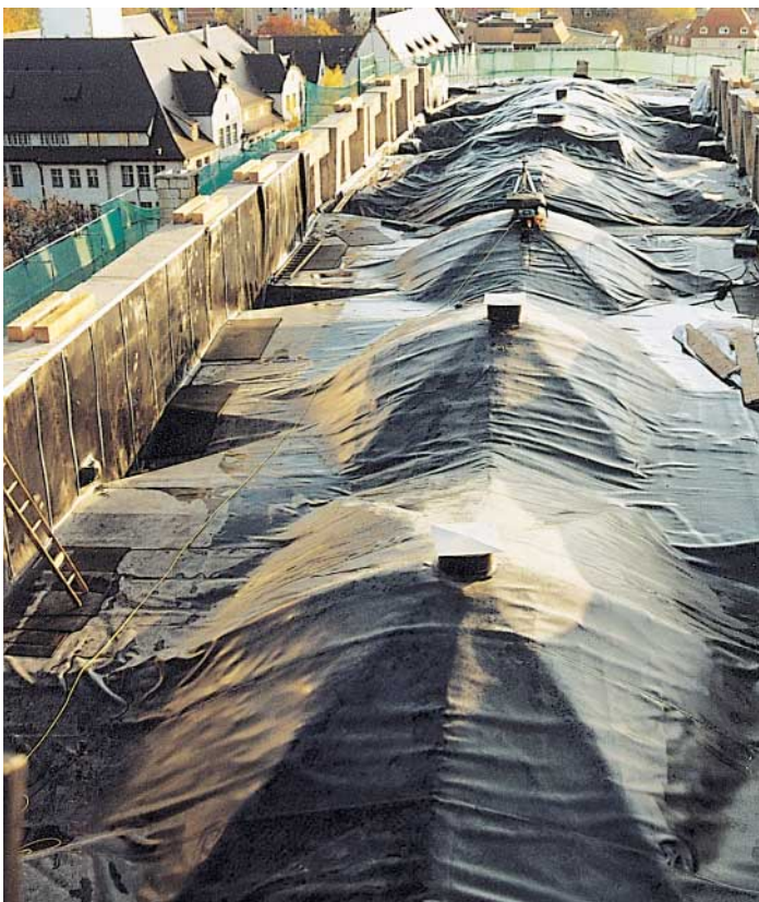
Abb. 5: Mit Abdichtung versehene Gewölbeoberseiten
